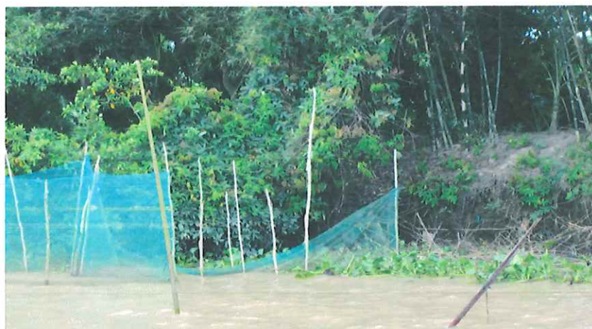
Hình 2.5 Hiện trạng xói lở hàm ếch rất nguy hiểm
