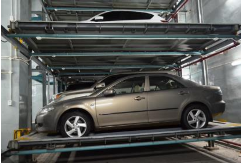
Hình 2.15. Hệ thống đỗ xe xoay vòng tầng tòa nhà 25 Hoàng Hoa Thám
