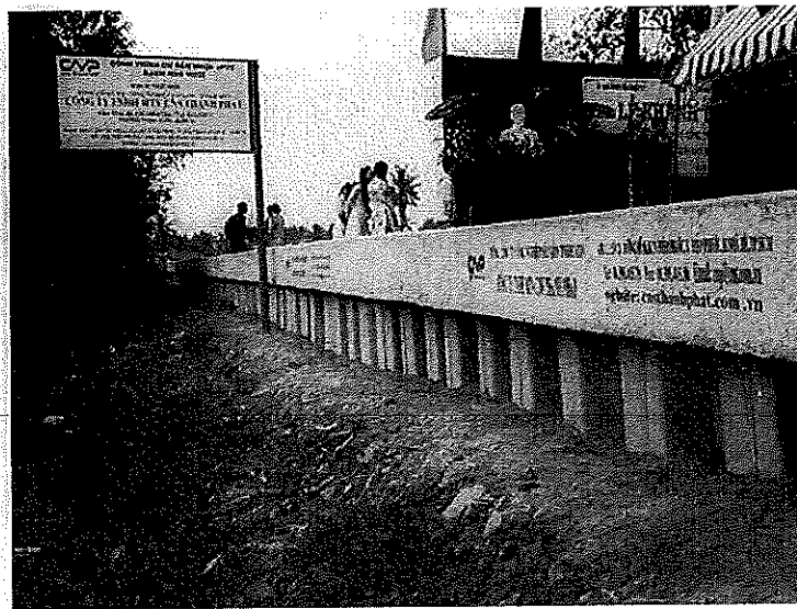
1-5: Công trình bằng cừ nhựa PVC Rạch Nhà Nuôi – Phường Thạnh Xuân, Quận 12 (Nguồn: Báo Vietnamnet)
