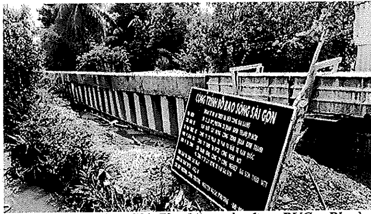
1-4: Công trình bờ bảo sông Sài Gòn bằng cừ nhựa PVC – Phường 28, Quận Bình Thạnh (Nguồn: Báo Nhân dân)
