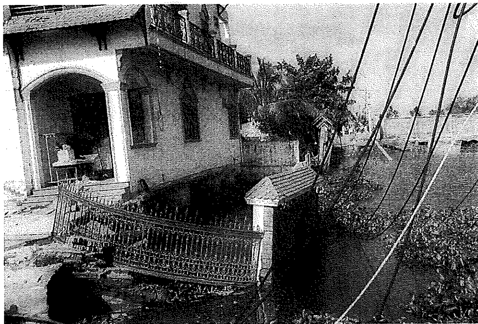
1-2: Sạt lở tại bờ sông Sài Gòn, Khu vực Thủ Đức
