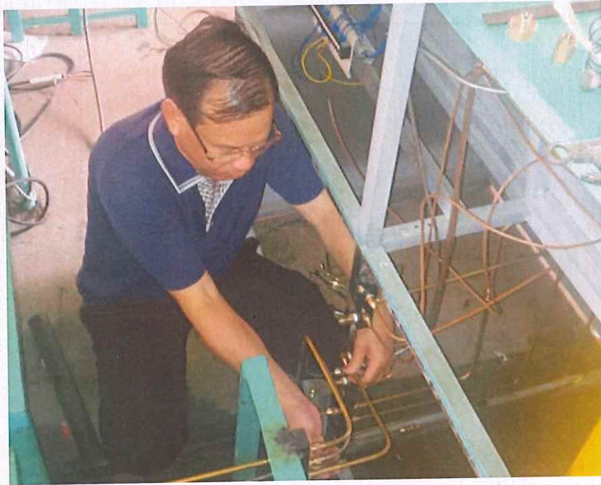
Hình 3.28. Đi đường ống kết nối hệ thống
