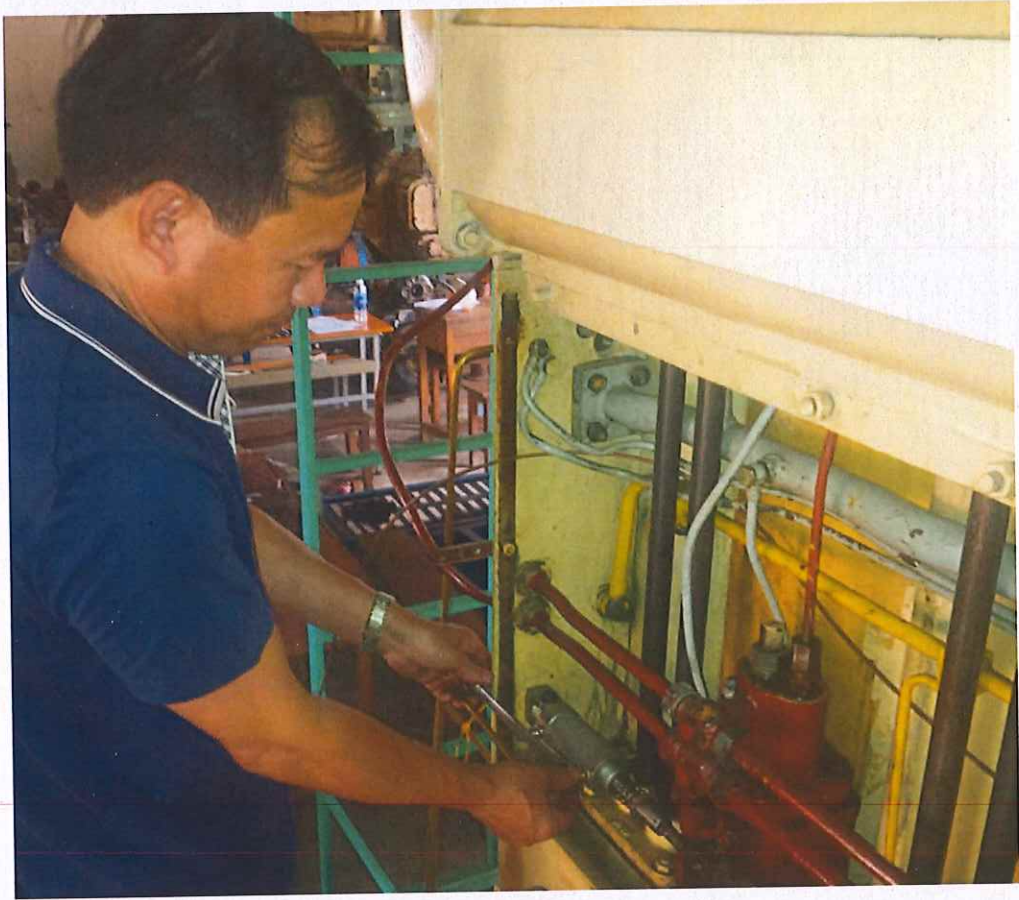
Hình 3.26. Lắp đặt các thiết bị cho hệ thống
