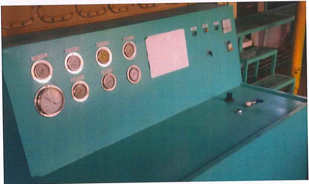
Hình 3.27. Lắp đặt bàn điều khiển
