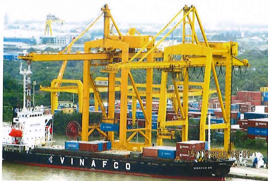
Hình 2.15 Cầu Gantry (QC)
