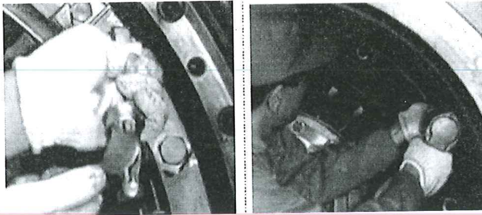
Hình 3-19 Lấy dầu bulong và tháo các bulong
