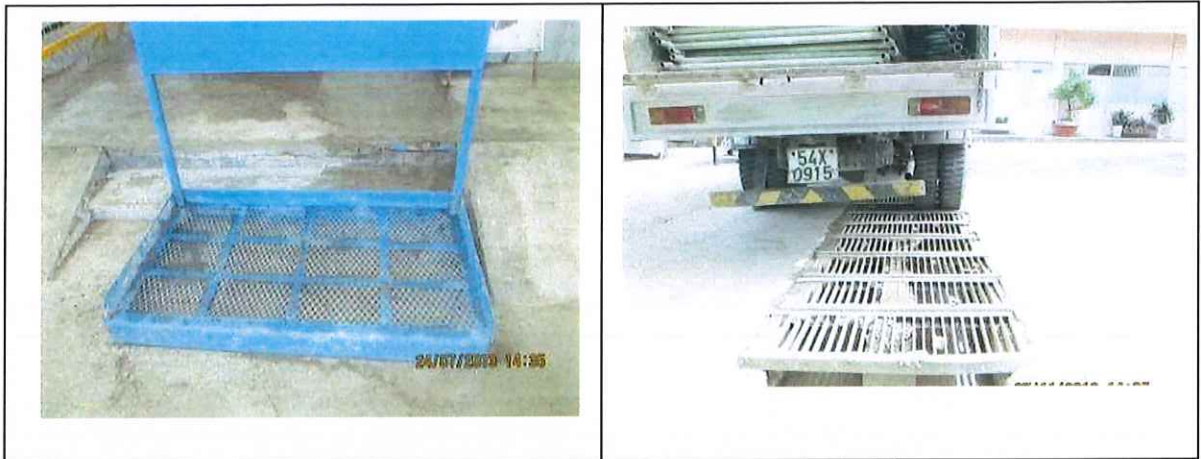
Hình 3.2 - Khu vực rửa chân, khu vực rửa xe có thiết kế khe thu nước
