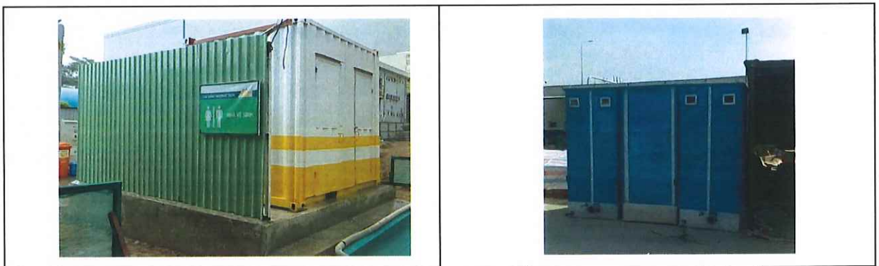
Hình 3.3 - Nhà vệ sinh công trường và nhà vệ sinh tạm trên các sàn tầng.
