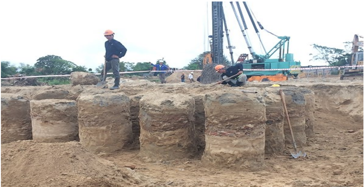
Hình 1.4. Gia cố nền đất yếu bằng CĐXM.
