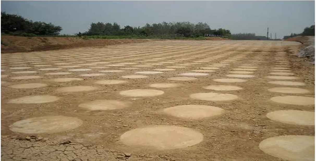
Hình 1.3. Gia cố nền đất yếu bằng CĐXM.
